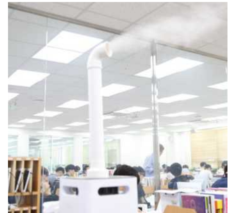
대형 가습기 설치/반별 통유리로 구획 구분
